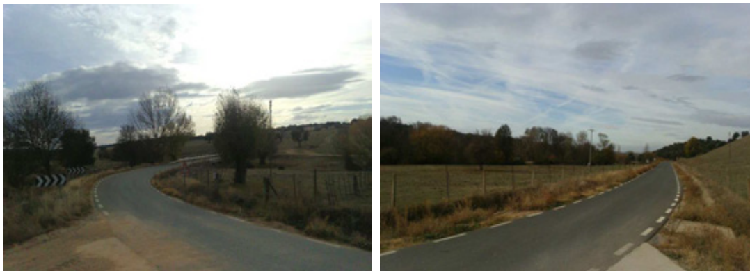
Imágenes de la Carretera DSA-130.
